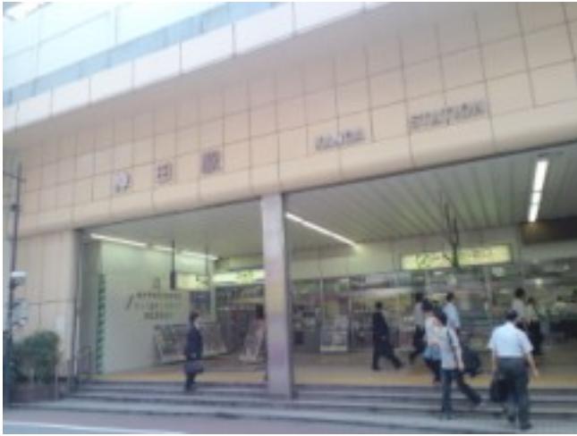
改良工事が待たれるJR神田駅
